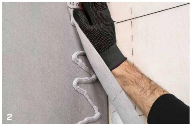
CONNESSIONE MEMBRANA IN COPERTURA - CALCESTRUZZO
